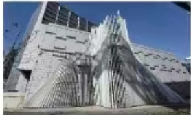
风塔 (现状, 后续改造为LED屏幕)
